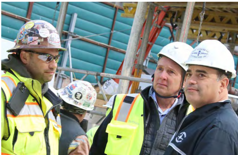
Anthony Frias III e Rodney Frias, ambos da S&F Concrete, durante os trabalhos na Winthrop Tower em Boston.
